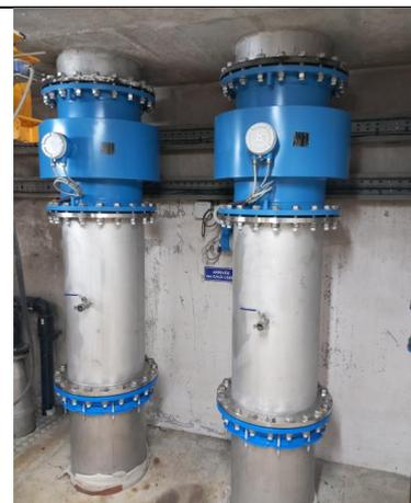
Fig.4c : Renouvellement des débitmètres entrée station Goilard
