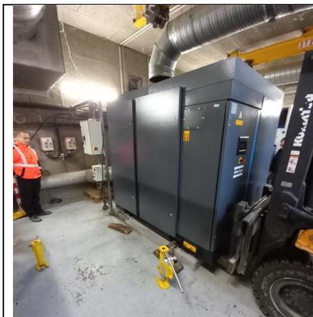
Fig. 4a : Mise en place du nouveau surpresseur
